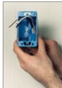
Insert Wires
